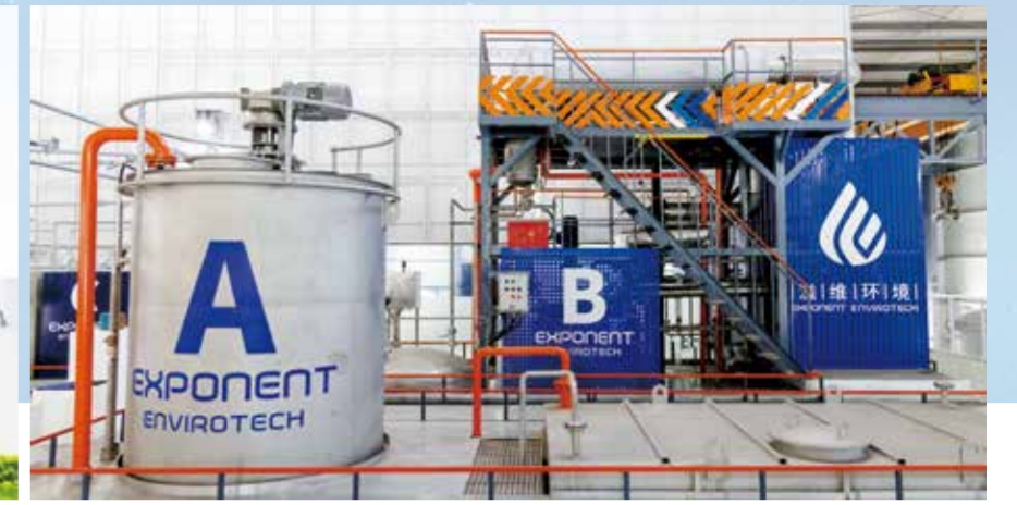
广东溢维环境科技有限公司非水染色技术生产车间。
